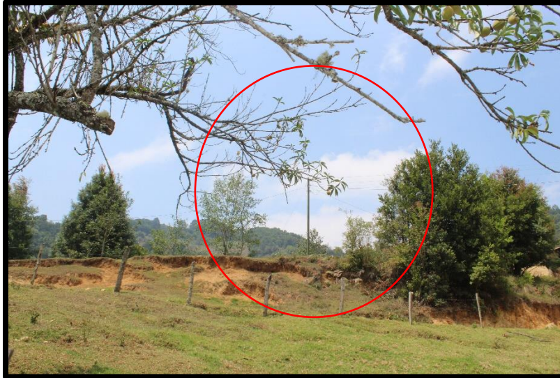
Fotografía No. 19 Vista de los postes y tendido eléctrico, previo al área de impacto.
